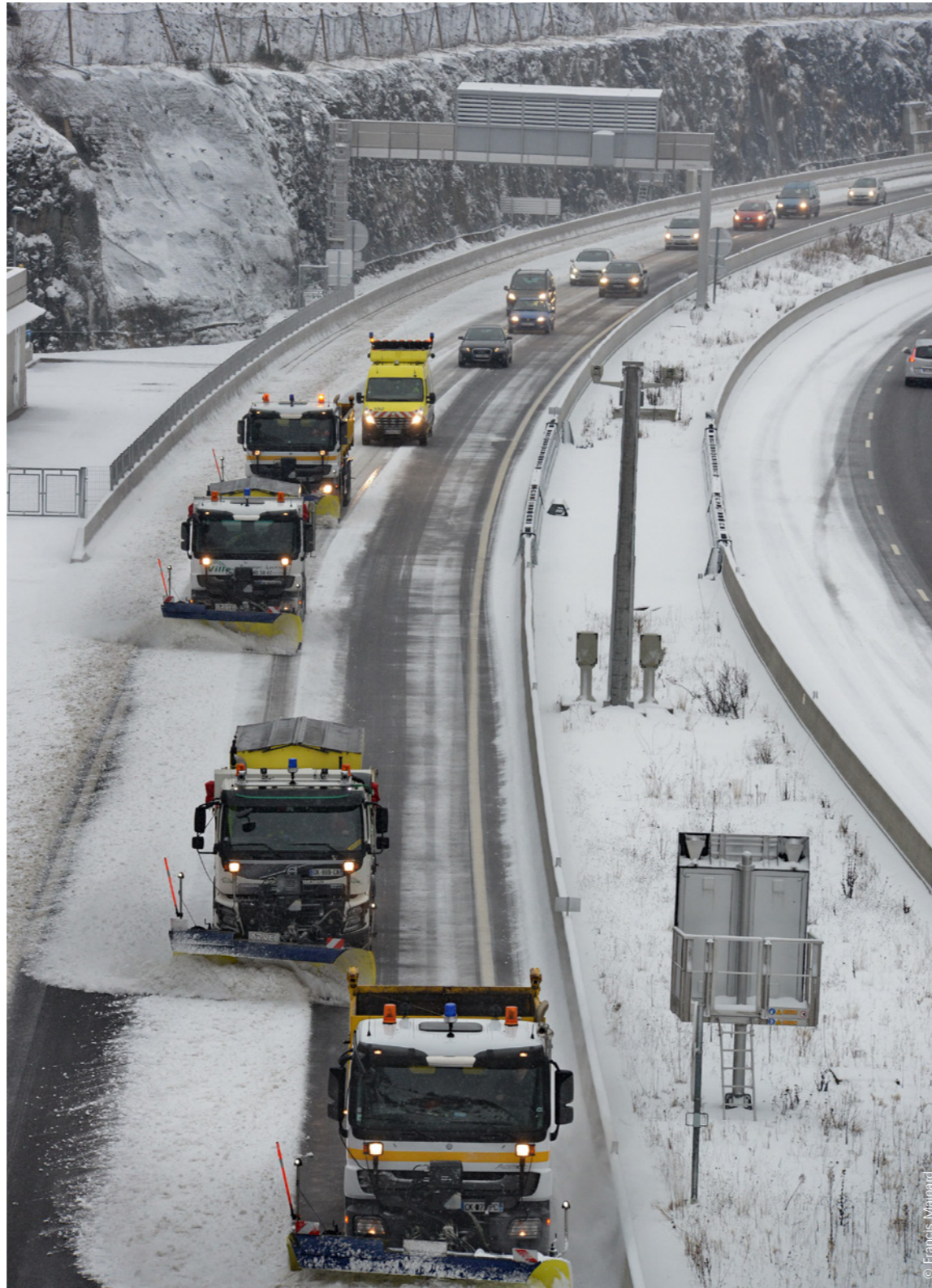
L'A89 déneigée en janvier 2016.
