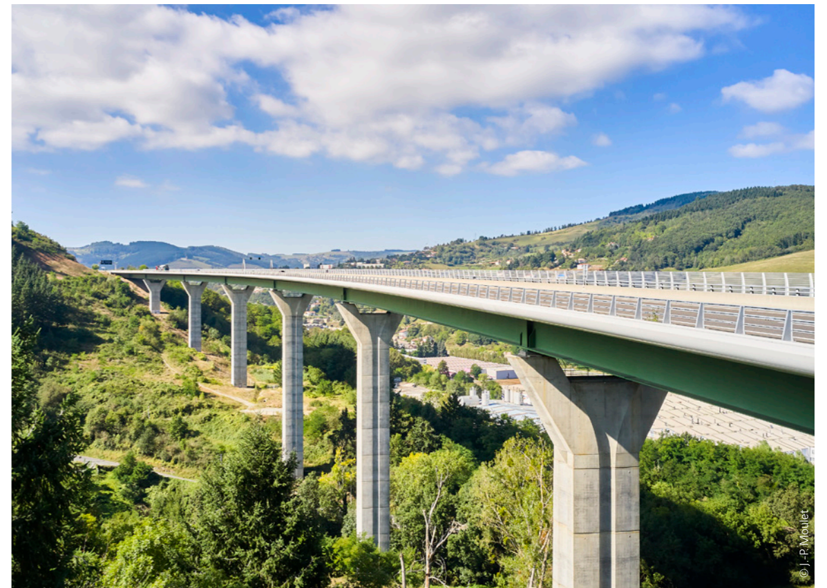
Viaduc de Goutte Vignole (section Tarare-Ouest - Tarare-Est).
