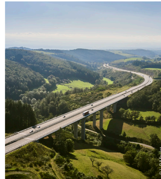
Viaduc du Gonon (section Balbigny - Tarare-Ouest).
