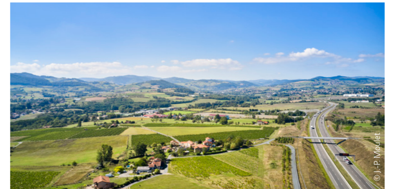
Intégration paysagère de l'A89.
