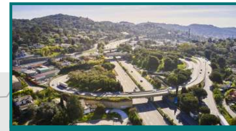
A8 Amélioration de l'échangeur de Mougins. Objectif : réduire les congestions et renforcer la sécurité
