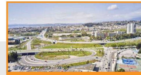
A8 / Voie Mathis Raccordement de la voie Mathis à l'A8 en tranchée couverte. Objectif : simplifier l'accès de la voie Mathis vers l'A8.
