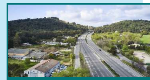
A8 Création de l'échangeur des Bréguières. Objectif : offrir un nouvel accès à Sophia-Antipolis
