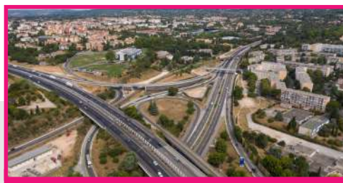
A8/A51 Réaménagement du nœud entre l'A8 et l'A51. Objectif : faciliter les insertions vers Marseille et Gap
