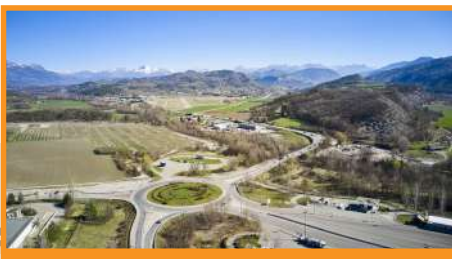
A51 Réaménagement de la RN 85. Objectif : améliorer la desserte de Gap depuis la sortie de l'A51
