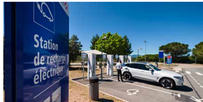
Les bornes de recharge vont être généralisées sur l'ensemble du réseau VINCI Autoroutes d'ici fin 2023. ©Photothèque VINCI Autoroutes.
